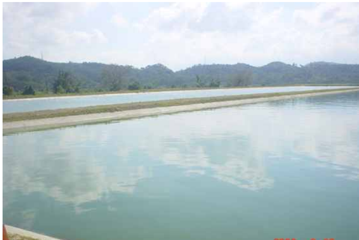
Laguna de oxidación para el centro de la ciudad de Choloma.
