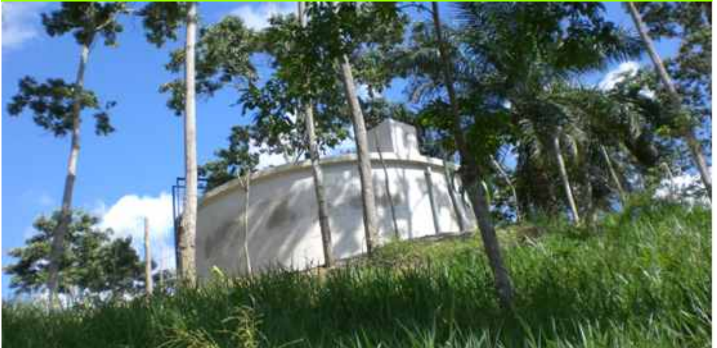
Tanque de capitación de almacenamiento contruido para la comunidad de Cuyamelito, Cortés.
