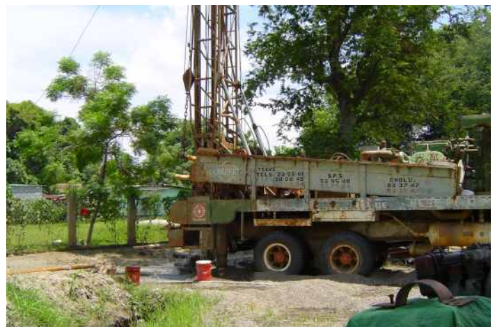
Construcción de un pozo con 300 pies de profundidad y doce pulgadas de diámetro.
