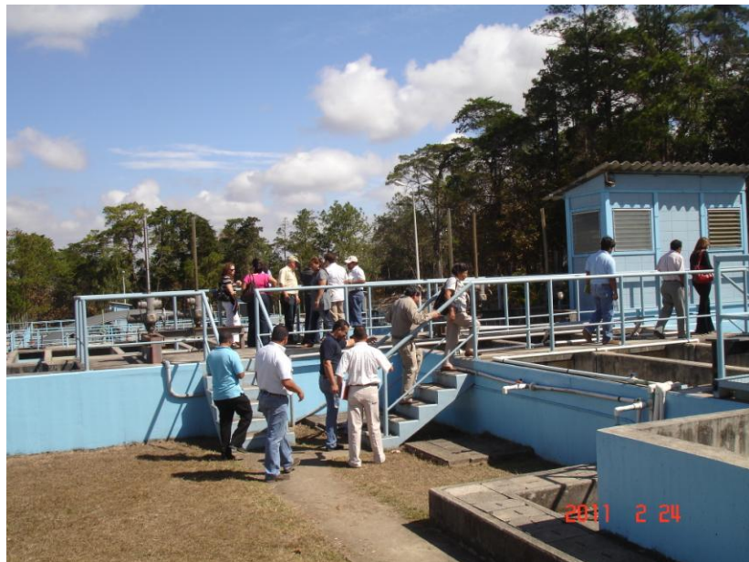
Gira a la Planta Potabilizadora el Picacho del SANAA.
